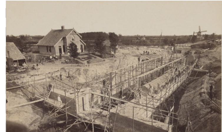
Bouw van de Koudhoornse Sluis in 1880
